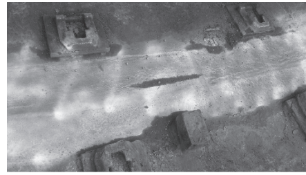
写真1 ガーダ上フランジ部の亀裂発生状況写真
