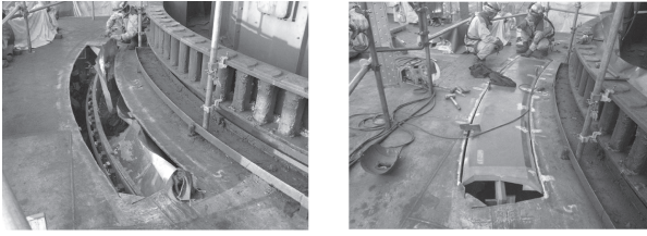
写真4 ポータルフレーム部分更新状況 Photo 4 State of partial renewal in portal frame
